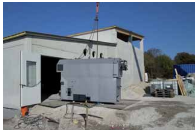
Foto: Montage des Brennkeessels in Moosach
