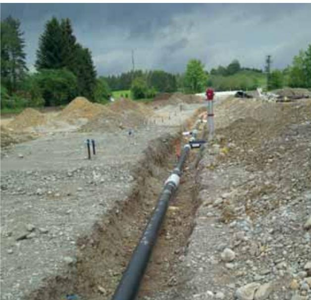
Foto: Bei der Verlegung ist die Überdeckung der Leitungen gering. Später, nach dem Bau der Straße beträgt sie 0,8m - 1m.
