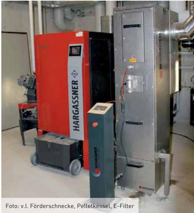
Foto: v.l. Förderschnecke, Pelletkessel, E-Filter
