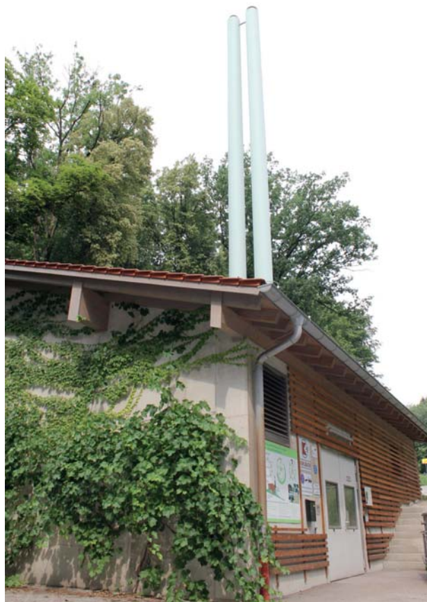
Foto: Heizhaus in Glonn
