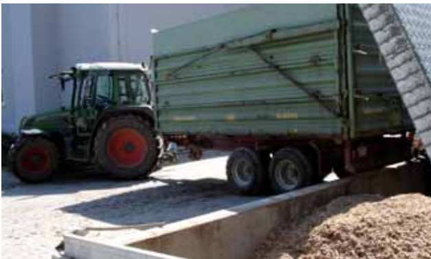
Foto: Abkippen in Heizwerk-Bunker
